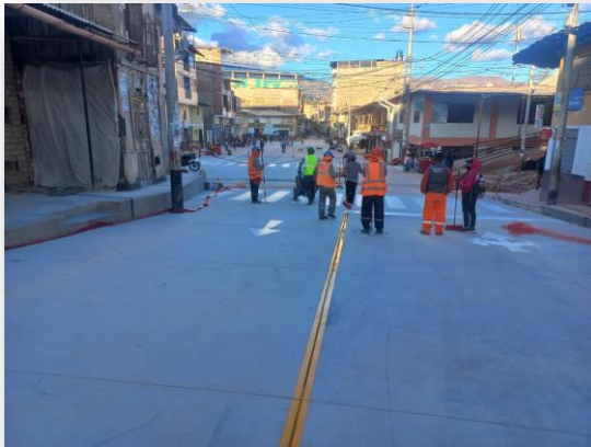
RECONSTRUCCIÓN DE PISTA Y VEREDA EN EL JIRÓN INCLÁN S/ 6,637,224.98 CONCLUIDA AL 100%
