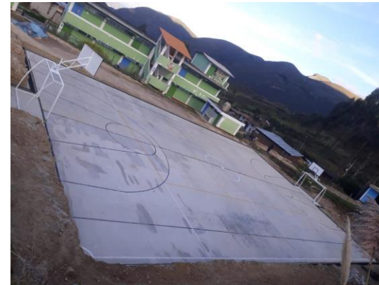
LOSA DE TINYAYOC S/ 229,227.10 CONCLUIDA AL 100%
