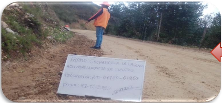
Mantenimiento rutinario Tramo: Cochamarca. Actividad: Limpieza de cunetas.
