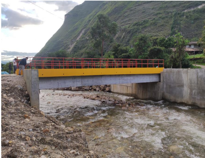
PUENTE PAUQUITA S/ 1'016,221.20 CONCLUIDA AL 100%
