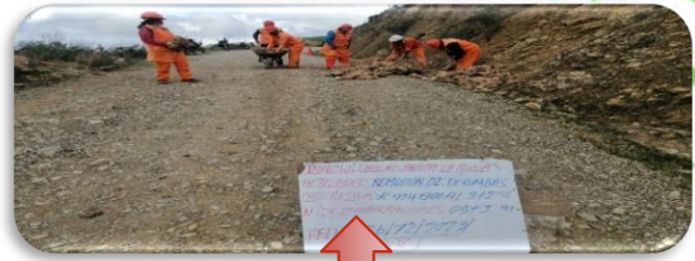
Mantenimiento rutinario Tramo: Shirac. Actividad: Remoción de derrumbes.
